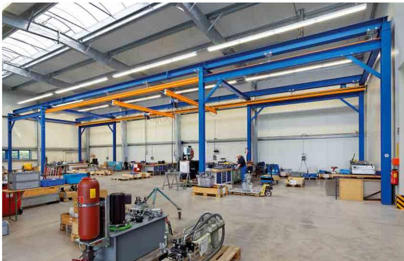
Individuell angepasste Portalstrukturen bieten Lösungen, wenn z.B. die Deckenkonstruktion nicht zur Befestigung der HB-Anlage geeignet ist. Es gibt sie freistehend oder auch mit seitlichen Anbindungen an die Hallenkonstruktion.
