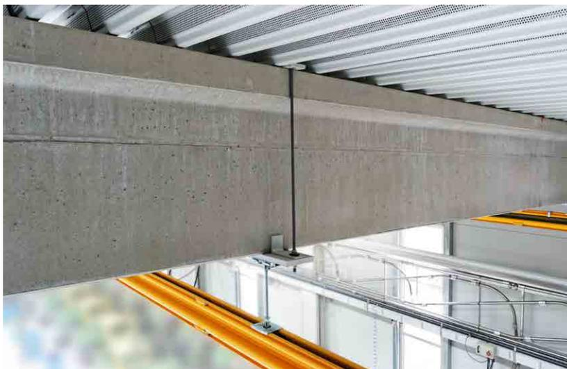
Die seitlichen Gewindestangen sind in der Länge variabel und ermöglichen die Verwendung auch bei großen Binderhöhen. Je nach Dachkonstruktion lassen sich Umklammerungskonsolen auch bei auf dem Hallenbinder aufliegenden Dächern montieren.
