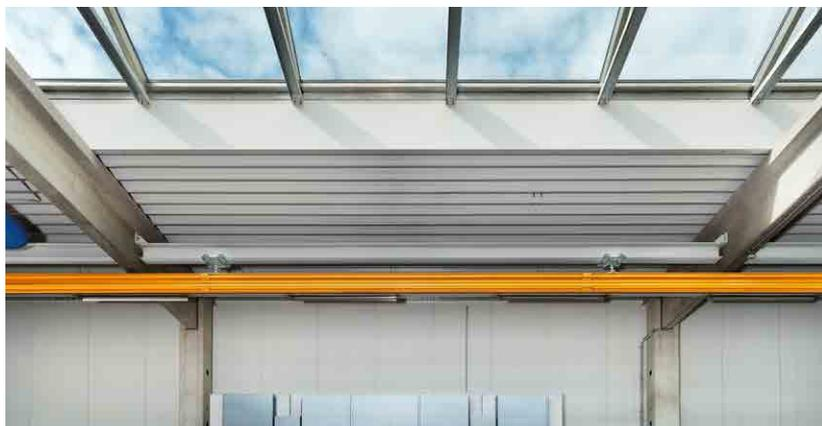
Hilfsträger schaffen zusätzliche Aufhängepositionen zur Abhängung der HB-Anlage. Sie werden frei gespannt an den Unterzügen der Halle befestigt und ermöglichen die Überbrückung auch großer Abstände.
